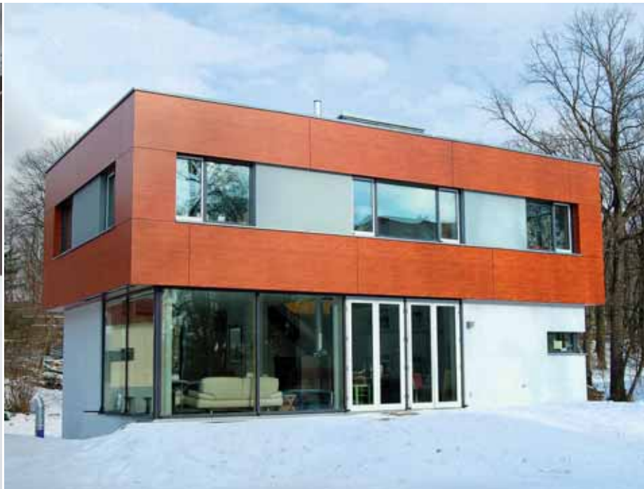
Passivhaus in Dresden (Foto: Olaf Reiter Architekten)
